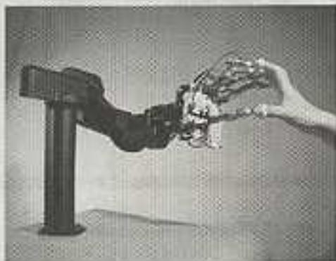
らに力覚を提示できるネットワーク触覚インターフェイス技術を確立。専用ホルダーを付けた自分の指をロボットの指と磁石接合し、画面に映し出された物体に触れると、その触感が指先に伝わる。
